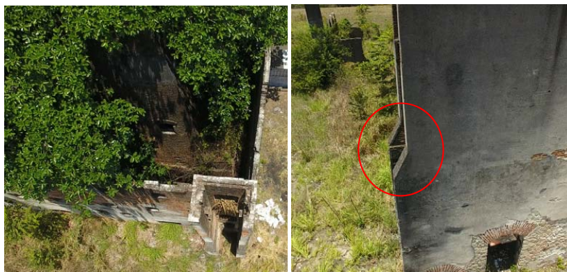
Figura 8 – Investigação de locais promissores à pesquisa de materiais cimentícios.
